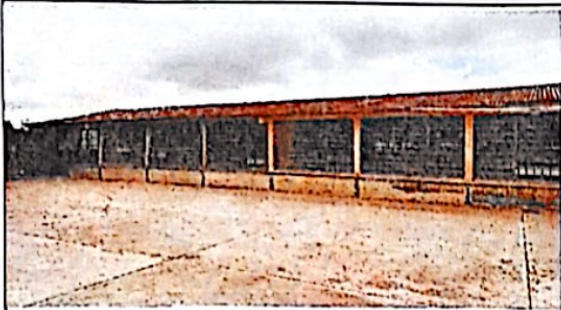
Foto 1: ANTES DE MANTENIMIENTO
