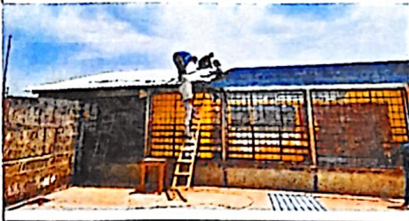
Foto 1: DURANTE EL CAMBIO DE TECHO
