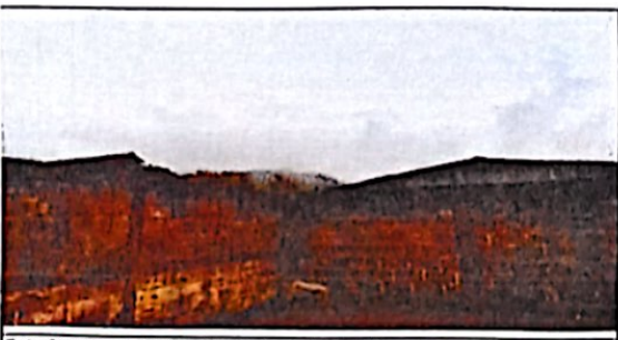
Foto 6: antes de antes del mantenimiento del muro y repello
