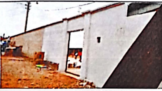
Foto 6: DURANTE EL EL LEVANTADO DE MURO Y REPELLO
