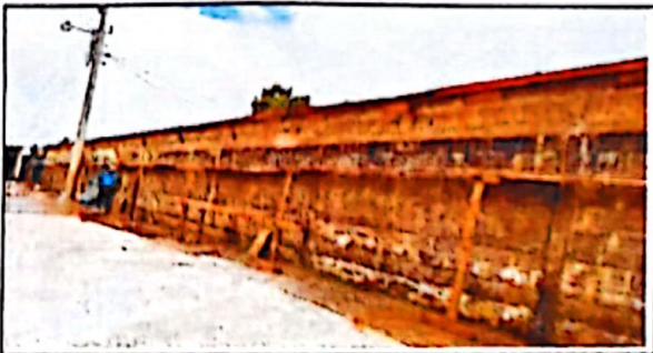
Foto 5: DURANTE EL EL LEVANTADO DE MURO Y REPELLO
