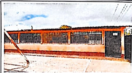
Foto 2: antes del cambio de techo
